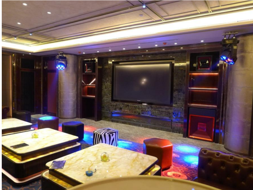
两只 Avalon CLUB.three 嵌装在电视墙两侧，安装高度是音箱底边距地 2 米。
