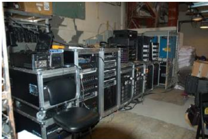
图 6：典型的临时机房
