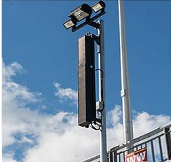
这个解决方案一共包含 14 个全天候的音箱阵列，每个阵列由一个低频和一个高频的多通道音箱模块组成。这些音箱阵列安装在铁杆上，覆盖南北球门区以及体育场西边的上层看台坐席。All Pro Sound 公司使用定制硬件安装主扩声音箱，覆盖上层看台的坐席。
